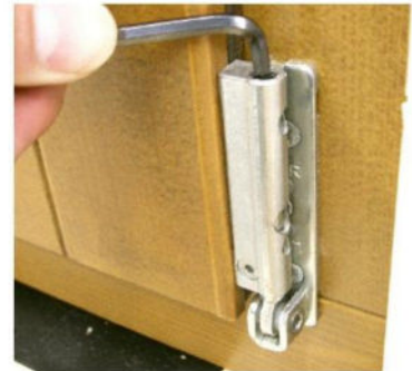
Slika 2: regulacija okovja NT/NX E5 - dvig krila
