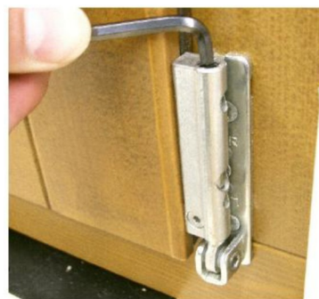
Slika 2: regulacija okovja NT/NX E5 - dvig krila
